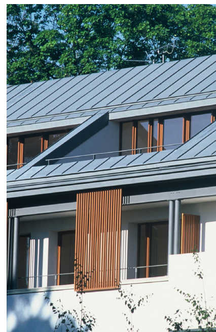
Residence, Praha (Česká republika) Architekti: Taieb
